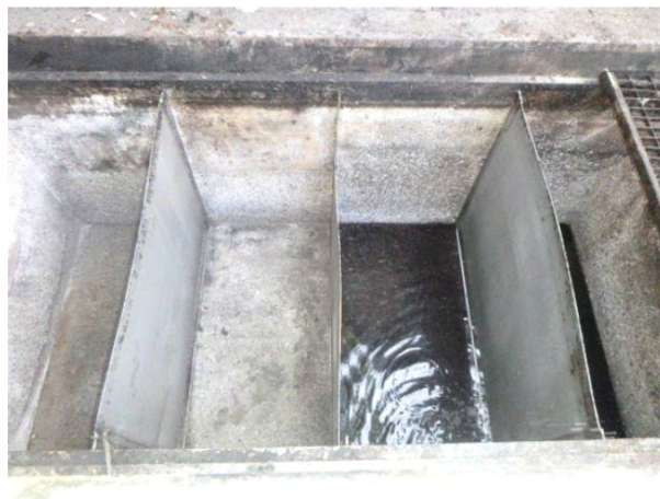
Fotonummer: 2 Omschrijving: Overzicht vetafscheider D.
